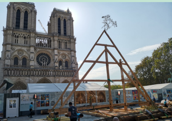
Chantier de Notre-Dame de Paris © D. Vomscheid, 2021
